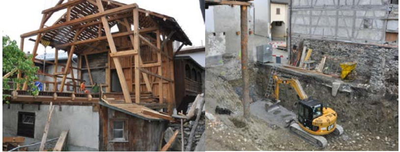
Der Stallabbruch markiert den Baubeginn
