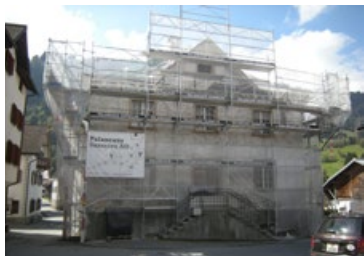
ALTES SCHULHAUS im Bagerüst
