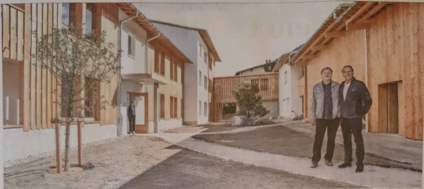
Ein Gegenüber von Wohnen und Arbeiten: Gion A. Caminada (links) und Martin Pfisterer führen durch die Überbauung Burggarta mit dem Erlihuus (hinten rechts).
